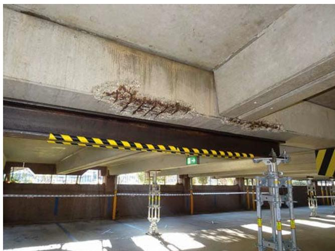
**Bild 7** Stahlbetonträger mit größeren Betonabplatzungen
