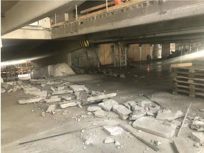
**Bild 8** Abbruch Deckenfeld zwischen bestehenden Spannbetonsträgern
