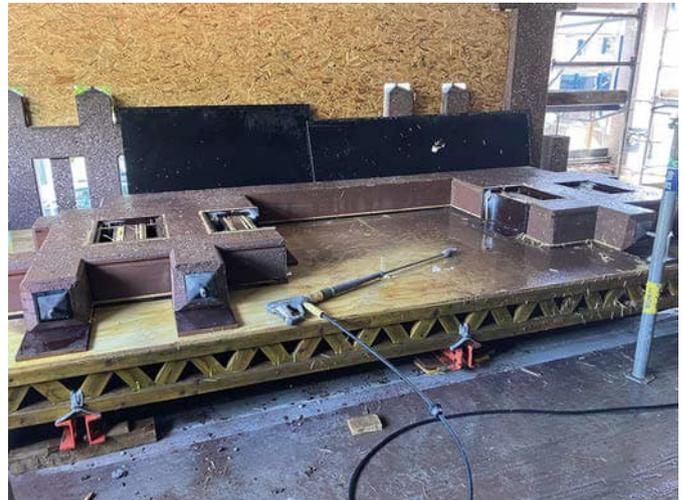
**Bild 15** Herstellung der Brüstungselemente mit baustellenseitig eingefärbtem Transportbeton und Oberflächenbearbeitung
