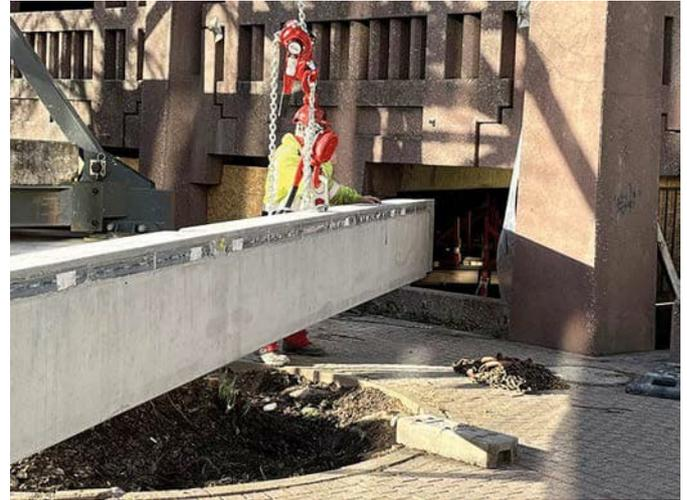
**Bild 10** Einfädeln eines Spannbetonsträgers durch die Fassadenelemente des Parkhauses
