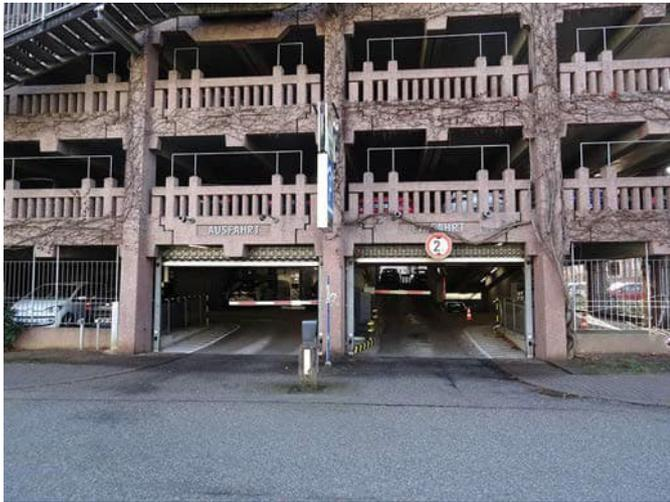
**Bild 2** Nordansicht der Parkhauses Stadtmittre in Landau mit Ein- und Ausfahrt; deutlich zu erkennen sind die Fertigteile der Fassadenkonstruktion
