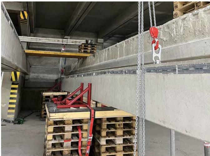
**Bild 12** Platzierung und Montage der neuen 16m langen Spannbetonträger
