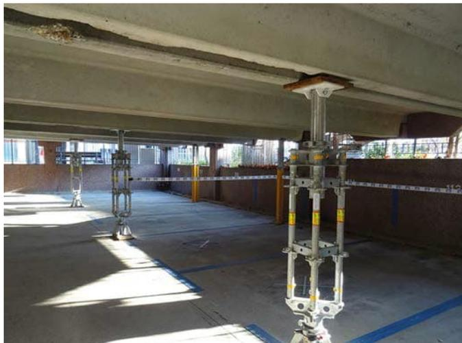
**Bild 5** Spannbetonträger mit größeren Betonabplatzungen und Stahlabfangung
