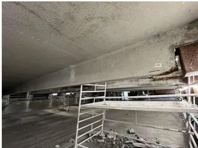
**Bild 6** Spannbetonträger mit größeren Betonabplatzungen im Auflagerbereich
