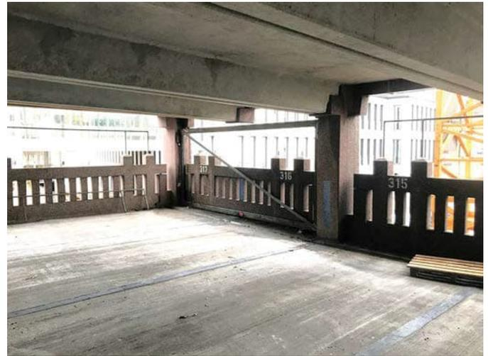
**Bild 3** Überblick über Fertigteilkonstruktion mit Spannbetonträgern, Deckenspiegeln und Fertigteilstützen sowie Brüstungselementen
