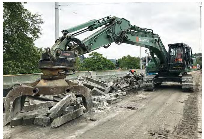
**Bild 8** Abheben der geschnittenen Kappenteile mit Kettenbagger
