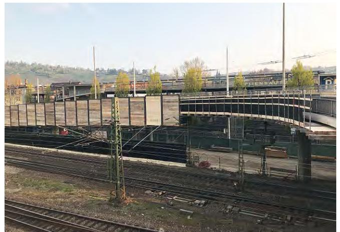
**Bild 6** Montierte Schutzwand und Traggerüst über dem Gleisbereich
