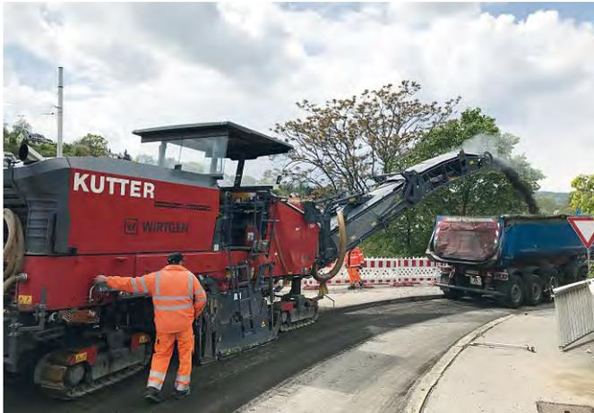
**Bild 3** Entfernung der Asphaltbeläge bis zur Abdichtung
