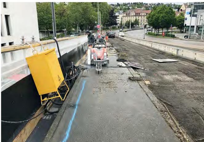
**Bild 7** Schneidevorgang am Kappengesims
